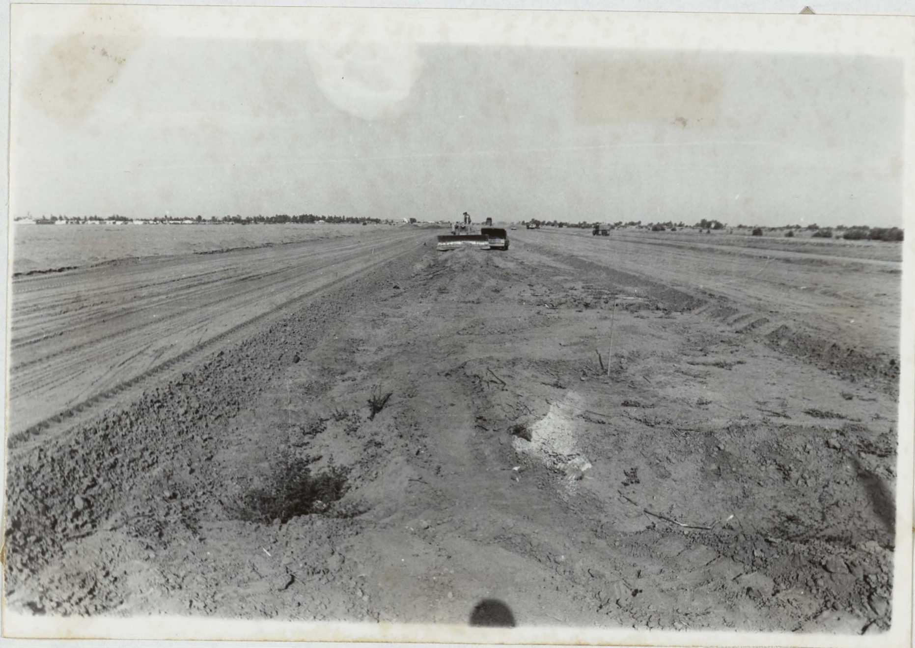
LAZARO CARDENAS (VILLAFONTANA) LIBRAMIENTO MEXICALI.
