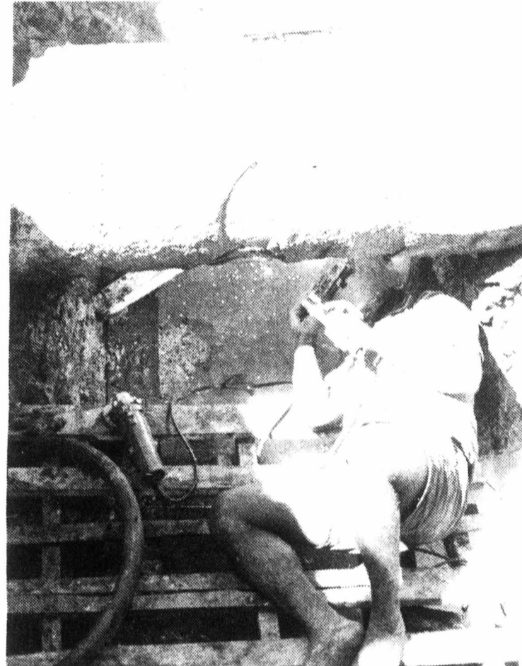
• Welda bilong JD Hayes Patrick Yakipu i wok long weldim dispela paip we i bruk.
