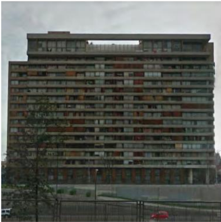
Fig. 4: fotografía del edificio a intervenir.
