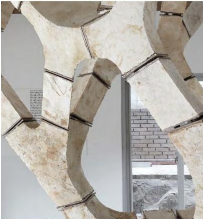
Fig_ 22: Detalle unión de componentes.
