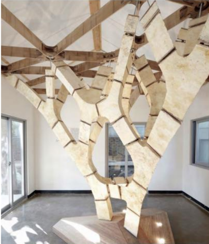
Fig_ 21: Estructura ramificada MycoTree.
