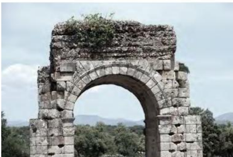
Fig_4: Arco Romano de Cáparra. Ejemplo de construcción en albañilería (ladrillos de piedra unidos con mortero).
