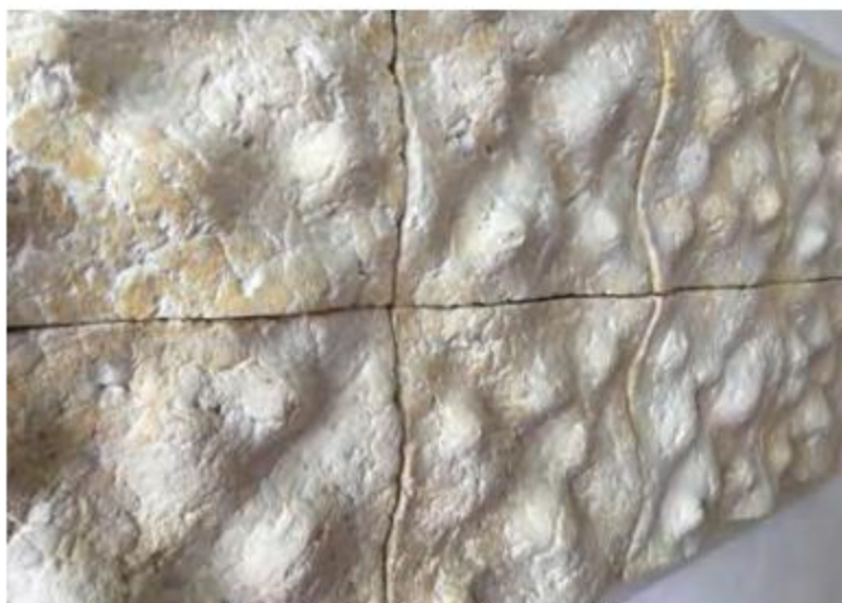
Fig. 11: detalle unión paneles
