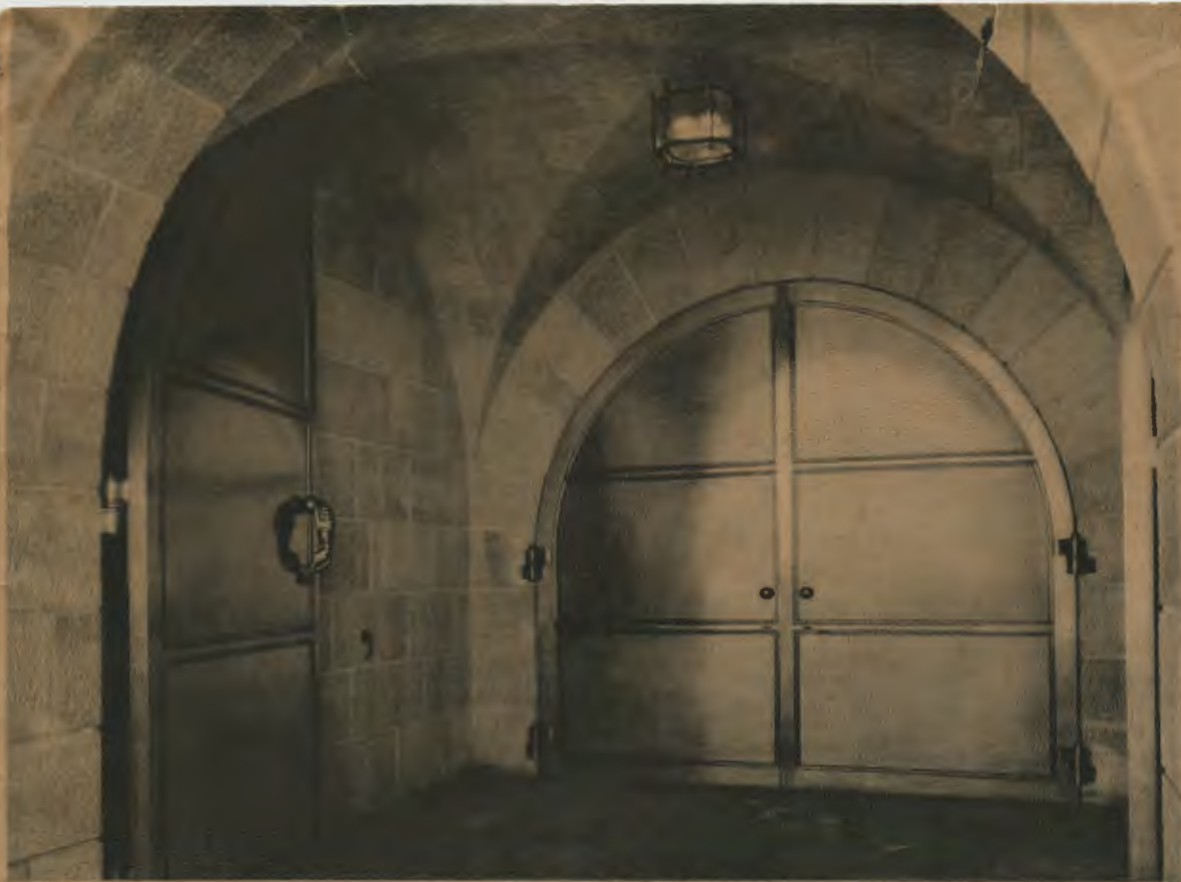
La double porte intérieure et extérieure du souterrain.
