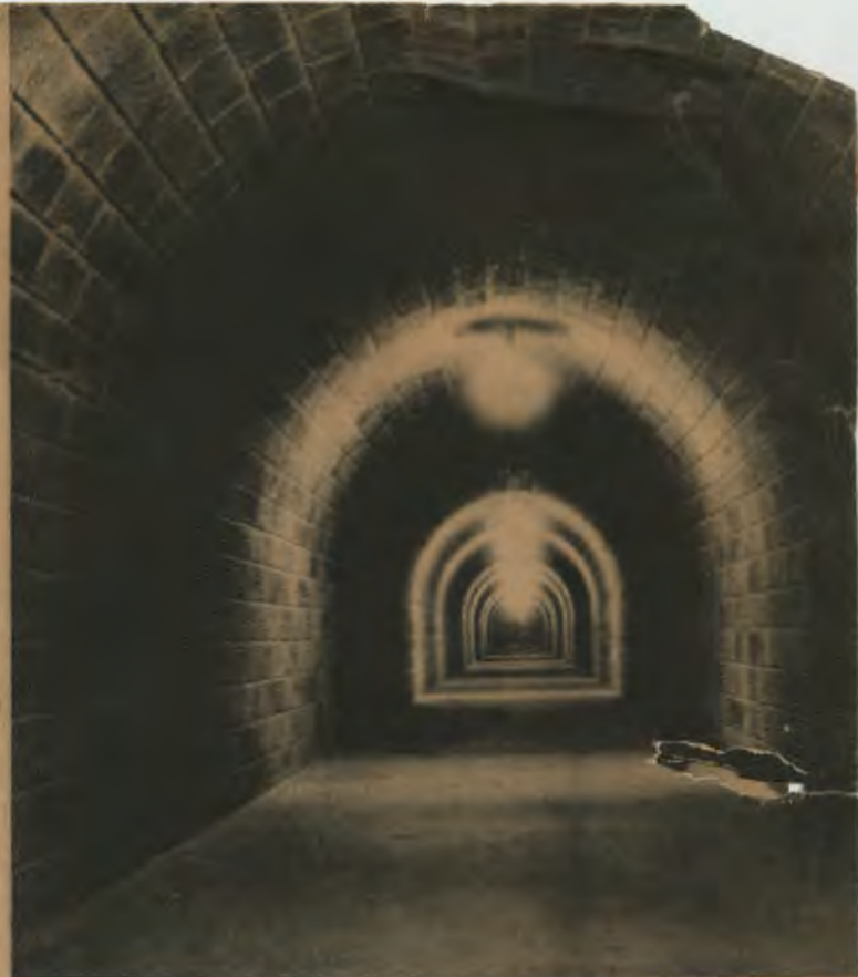
La galerie menant à l'ascenseur.
