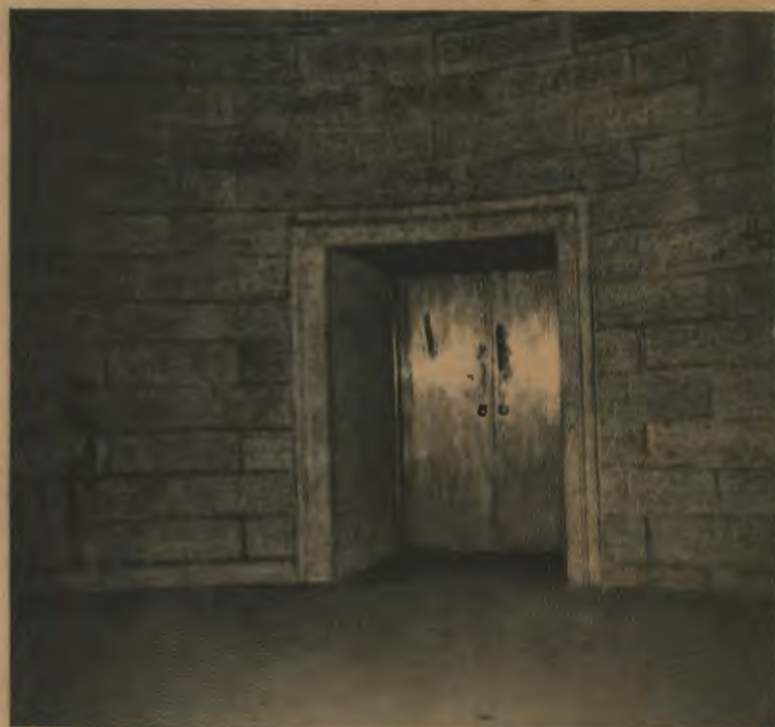
Les portes de l'ascenseur.
