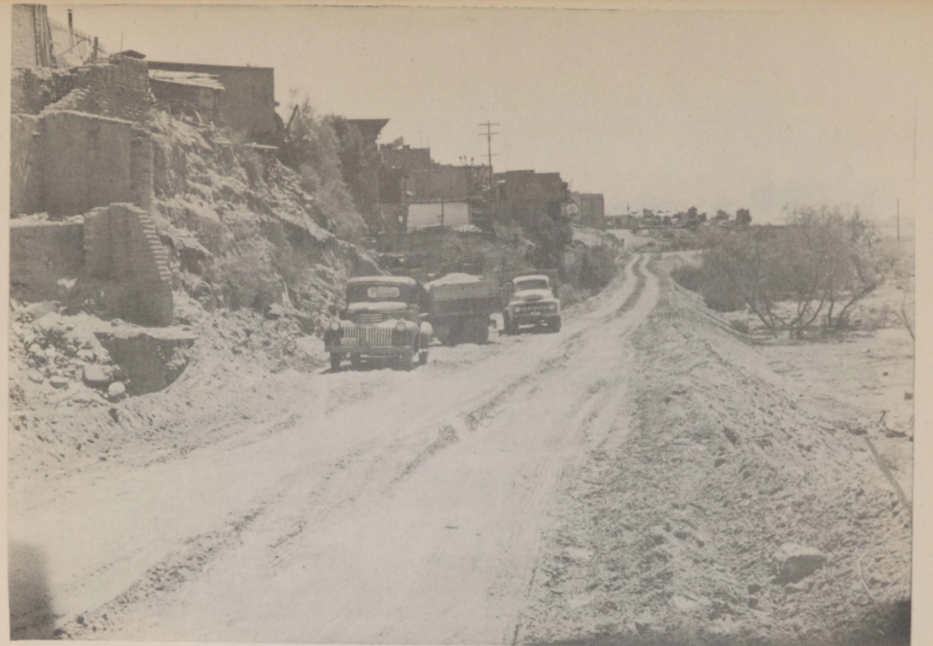
ASPECTO DE AFINACION DE TERRACERIA PARA COLOCAR GRAN COLECTOR EN LA MARGEN DERECHA DEL RIO NUEVO MEXICALI, BAJA CALIF.
