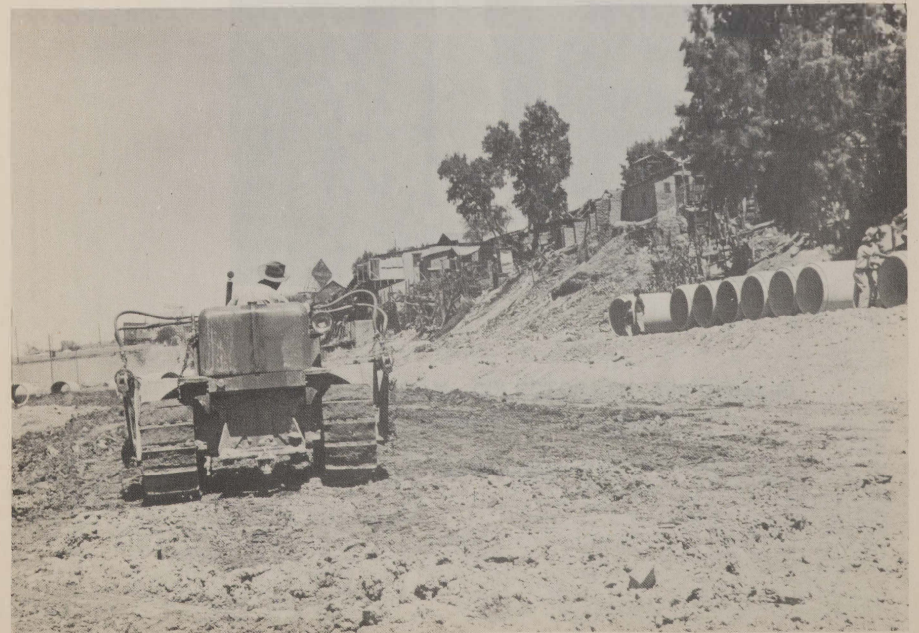
ASPECTO GRAL. TERRACERIA PARA GRAN COLECTOR EN EL RIO NUEVO ENTRE PUNTES "COLÓRADO" Y "MIGÜEL ALEMÁN" MEXICALI. BAJA CAL.
