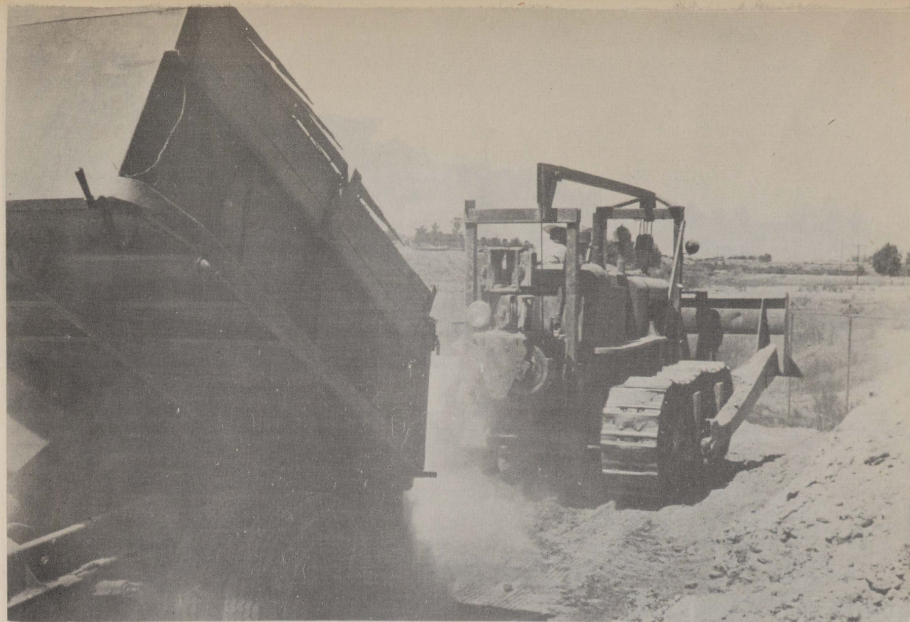
TERRACERIAS PARA GRAN COLECTOR RIO NUEVO Y LINEA DIVISORIA INTNAL.
