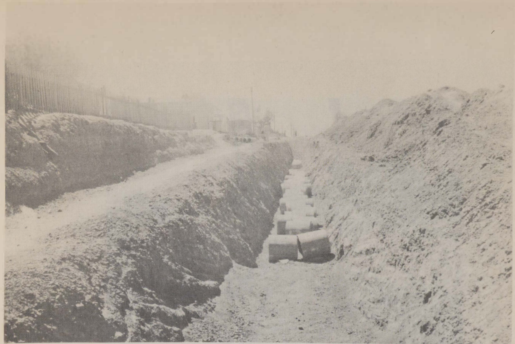
OBRAS DEL SUB COLECTOR EN CALLE "I"
