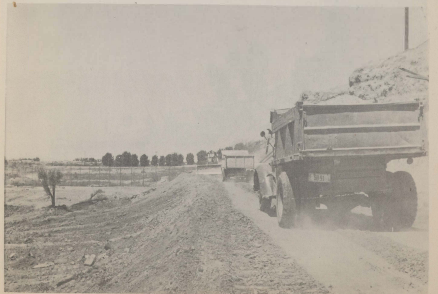
ASPECTO DE AFINACION DE TERRACERIA PARA COLOCAR GRAN COLECTOR EN LA MARGEN DERECHA DEL RIO NUEVO MEXICALI, BAJA CALIF.
