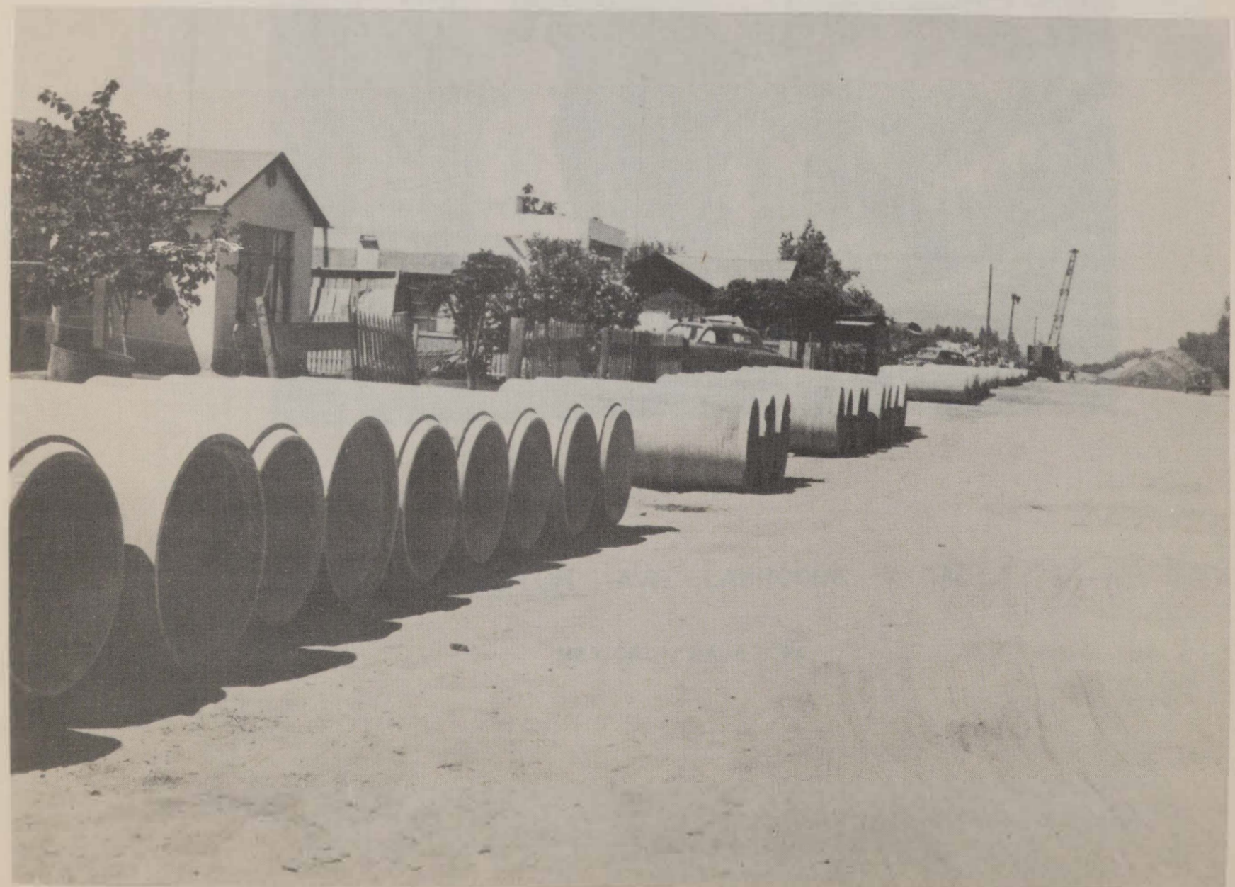
CONSTRUCCION GRAN COLECTOR AVE. LARROQUE ENTRE CALLES "H" E "I"
