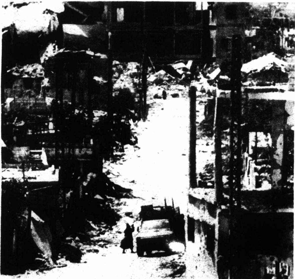
LEBANON 20 JUN — Taun ya em Sidon, Lebanon. Em i bagarap olgeta. Wanpela man na meri bilong em i kisim ol samting i no bagarap long haus bilong ol na utim long trak. Ol i laik ranawe nau.
