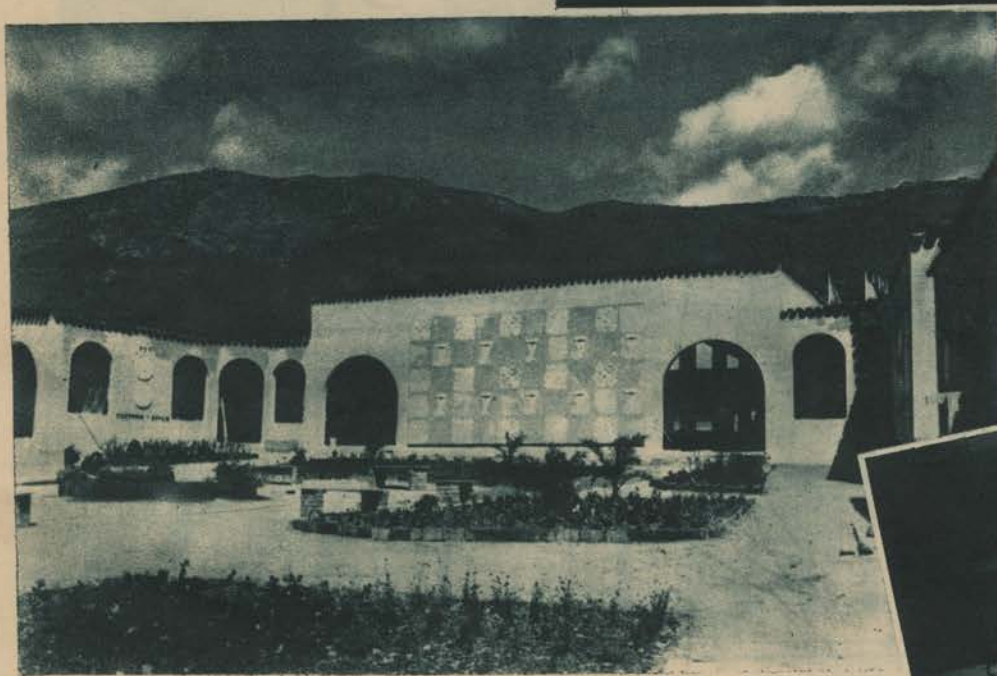
Aspecto parcial del patio central
