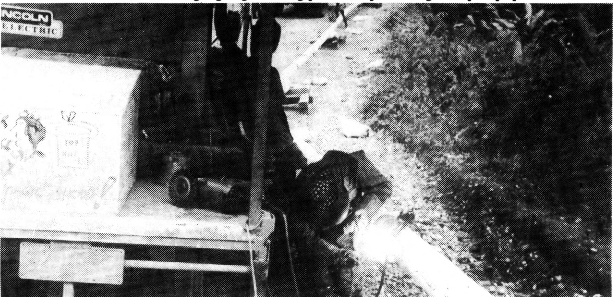
• Orait em i weldim nau tupela paip ya.
