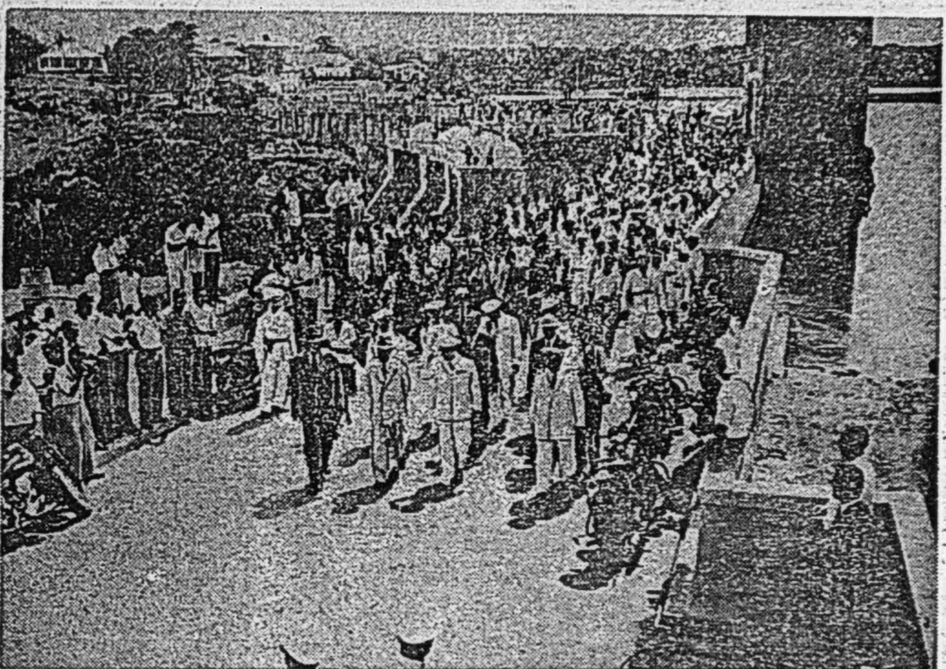
A visita do Chefe do Estado á barragem das Mabubas, em Angola
